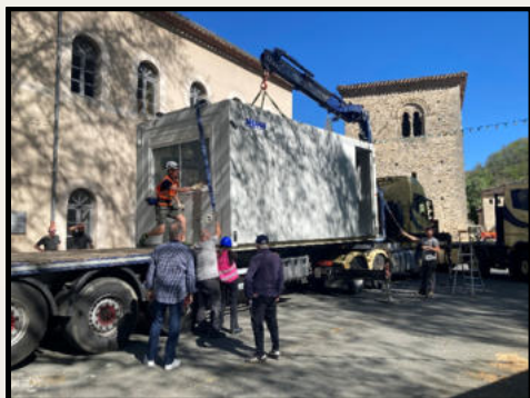
Installation de l'ALGECO quai Adélaïde
